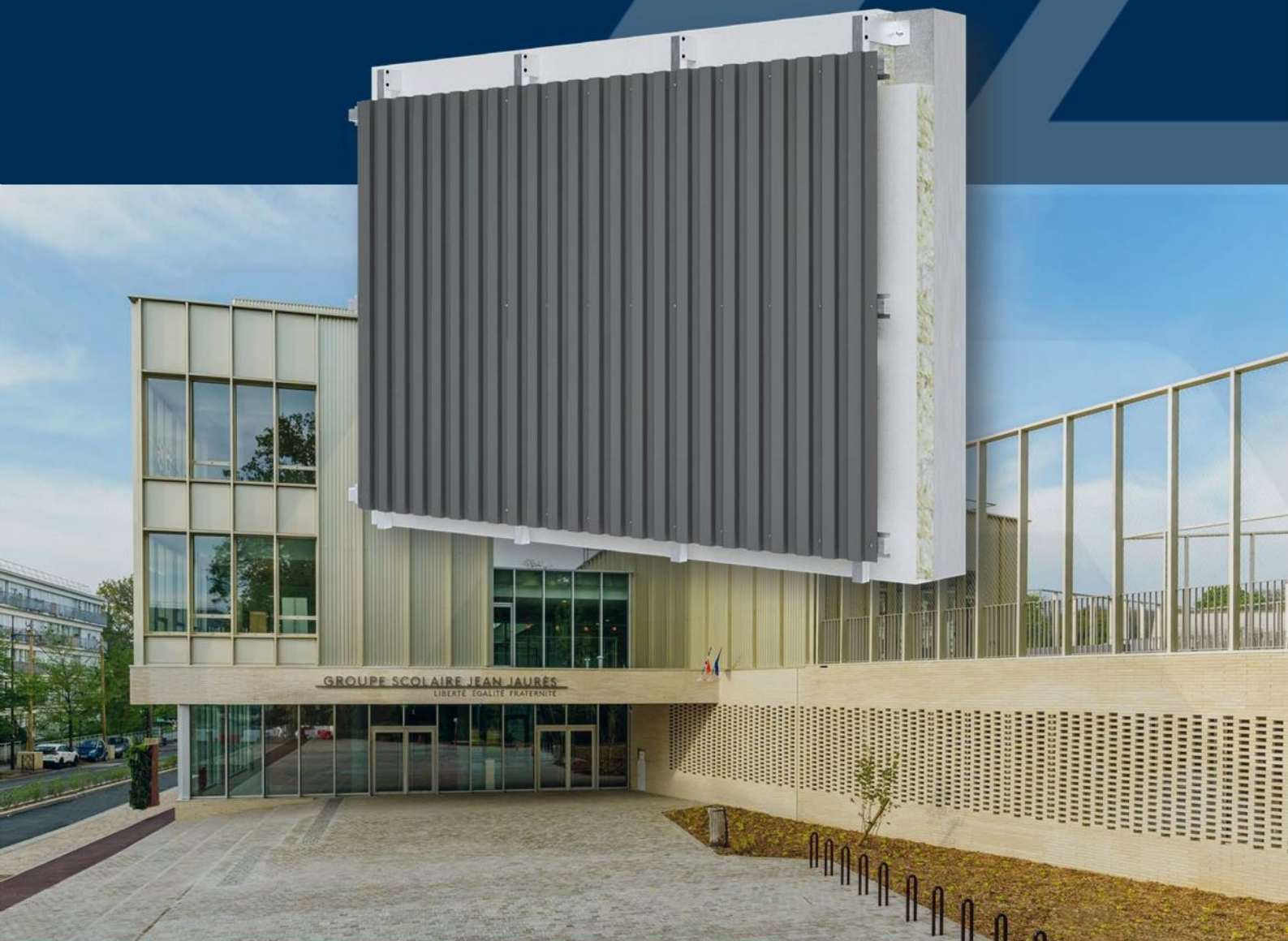
Groupe scolaire Jean Jaures à Châtenay Malabry // Nomade architectes
